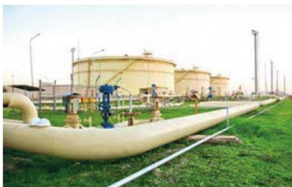
شکل ۲۰- نمایی از خطوط انتقال سوخت
