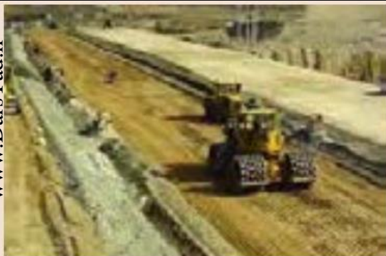
مراحل ساخت سد خاکی
